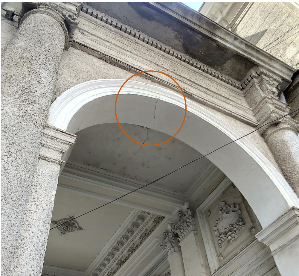
Foto nr. 8 – Fisură boltă gang înspre curtea interioară
