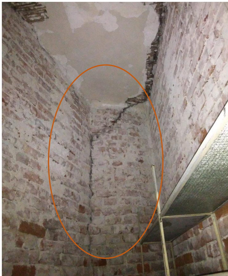
Foto nr. 6 – Fisură perete de zidărie spațiu adiacent gangului
