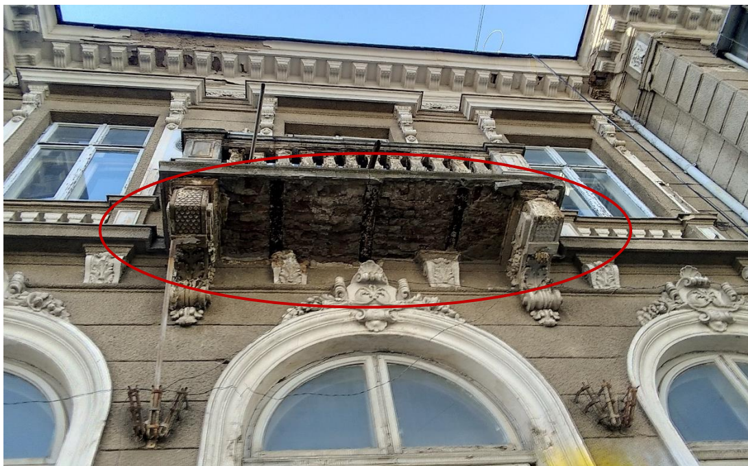
Figura 12 – Planșeu cu profile metalice și boltișoare cu tencuiala căzută
