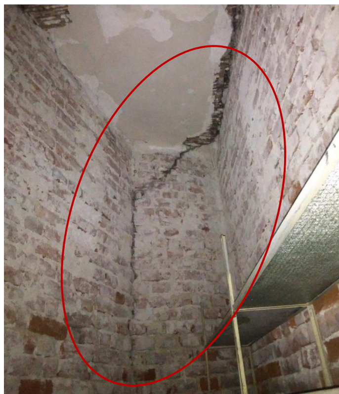
Figura 16 – Fisuri perete din zidărie
