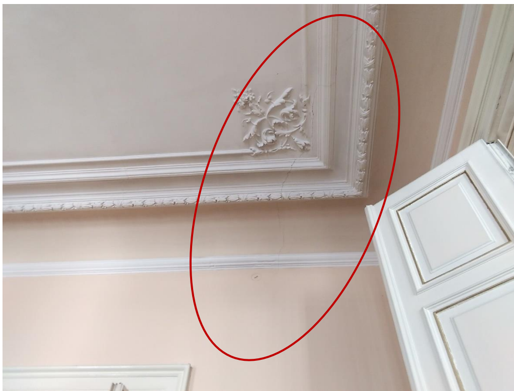
Figura 22 – Fisuri tavan etajul 1
