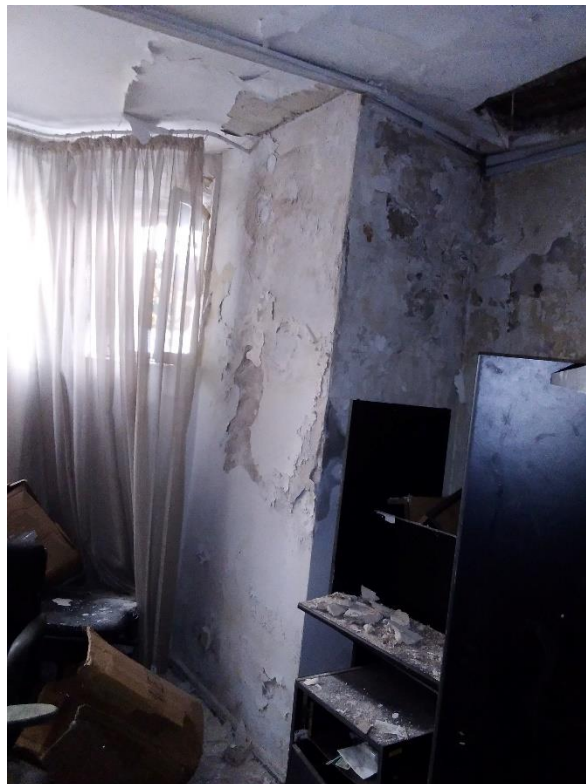
Foto nr. 12 – Degradări tencuială pereți subsol
