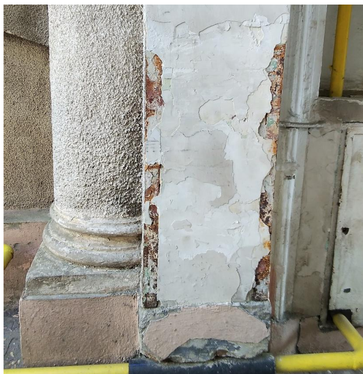
Figura 14 – Tencuială căzută stâlpi consolidați gang
