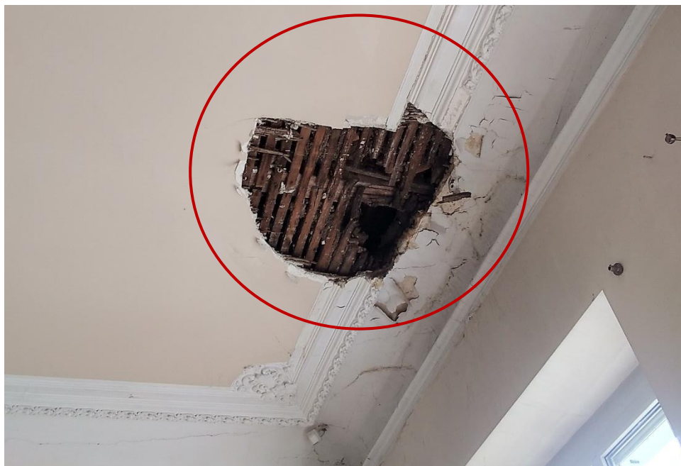
Figura 23 – Degradări planșeu de lemn peste etajul 1
