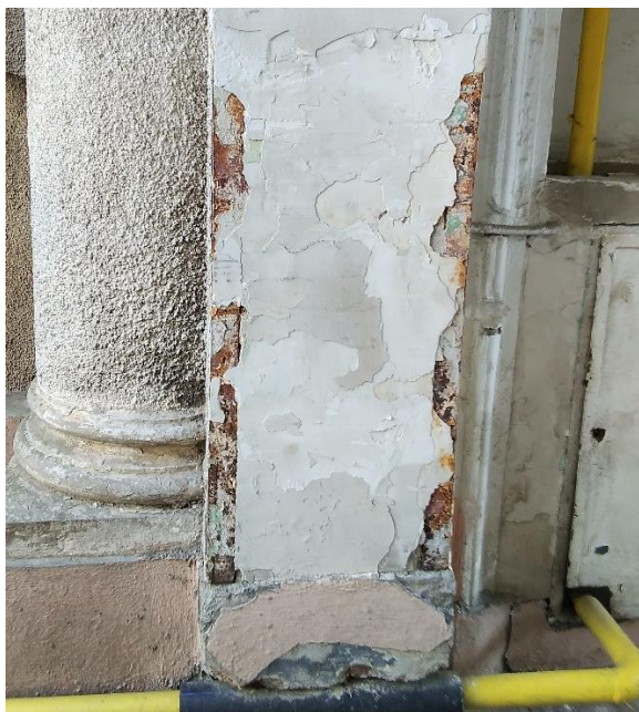
Foto nr. 9 – Tencuială căzută stâlpi consolidați gang
