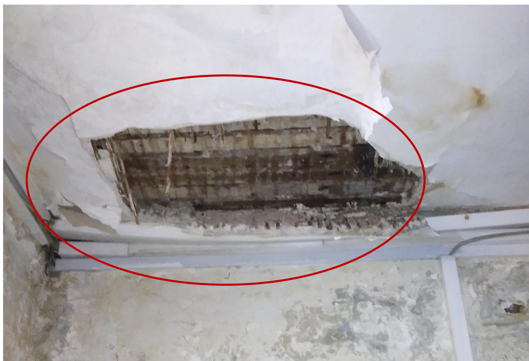
Figura 18 – Degradări tavan rabiț demisol
