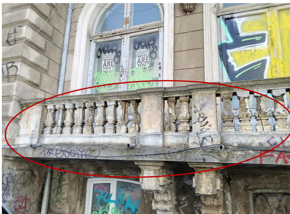
Figura 13 – Degradări balcon fațada înspre Calea Griviței
