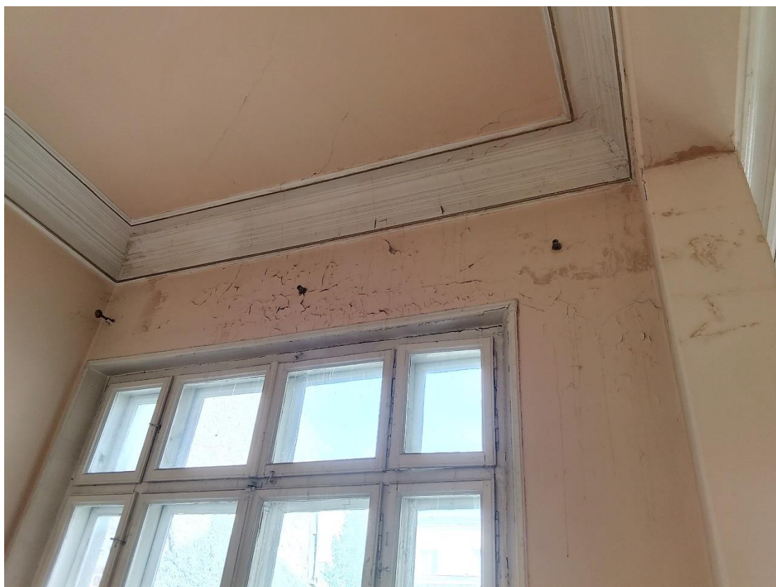
Foto nr. 16 – Degradări tencuială pereți etajul 1
