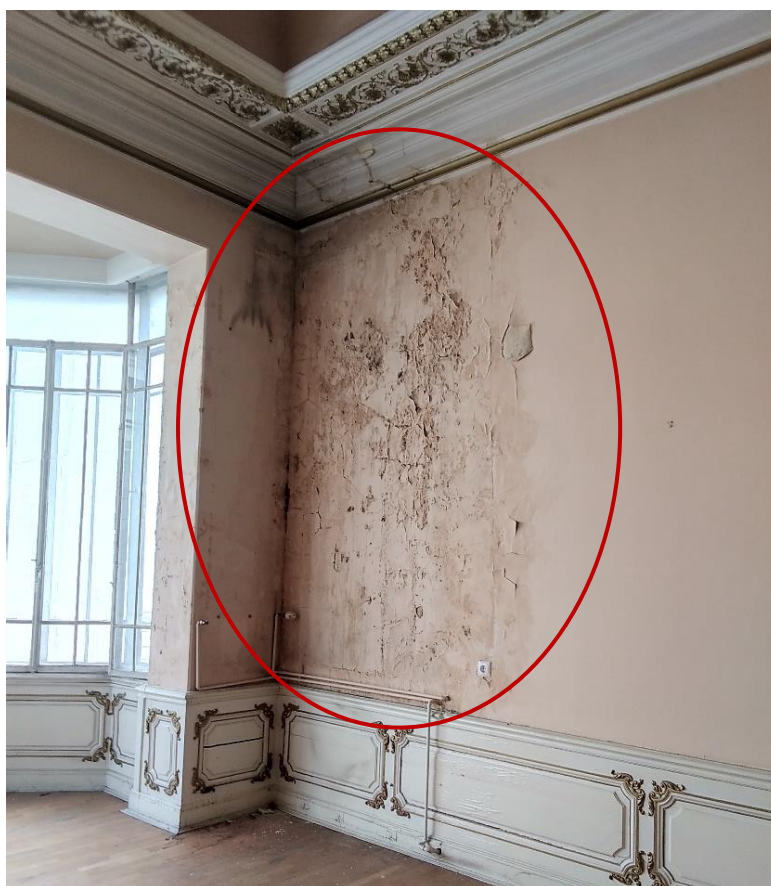
Figura 21 – Degradări pereți etajul 1
