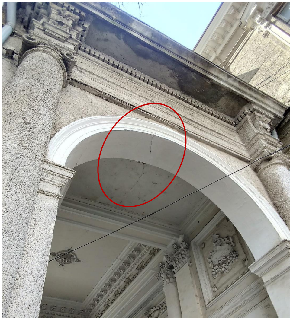
Figura 15 – Fisuri placă peste gang și fisuri boltă
