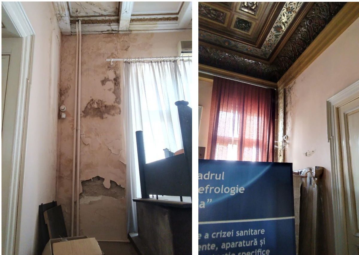
Foto nr. 14 – Degradări tencuială pereți parter
