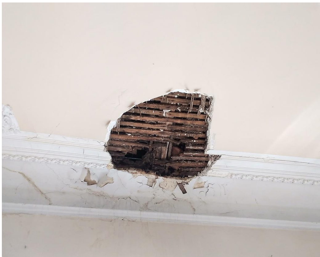
Foto nr. 18 – Degradări planșeu de lemn peste etajul 1
