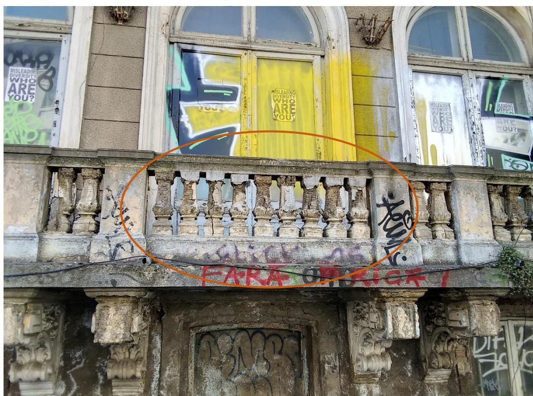
Foto nr. 5 – Degradări balcon fațada înspre Calea Griviței
