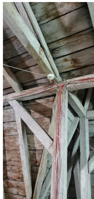
Foto nr. 25 – Cabluri amplasate pe structura de lemn
