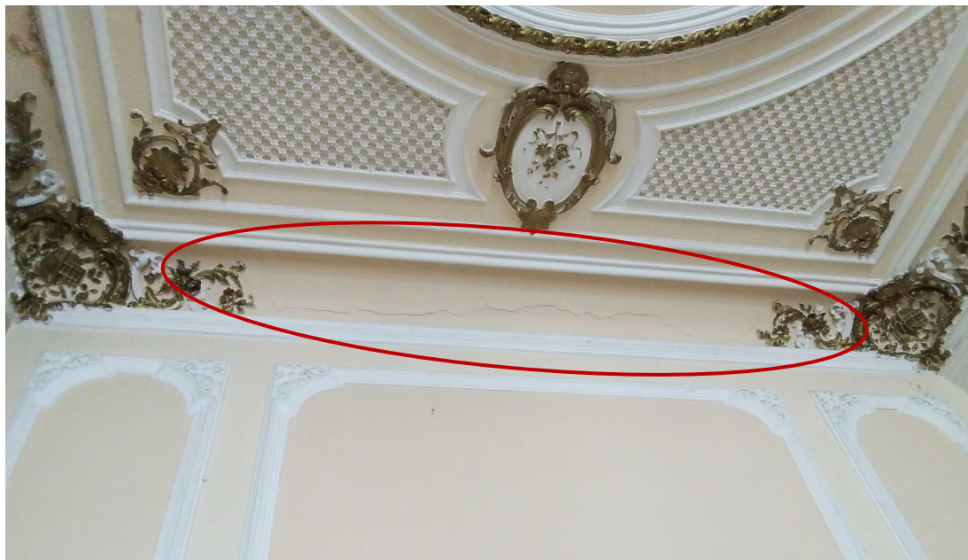
Figura 20 – Fisuri tavan parter
