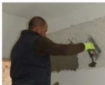
Figura 36 – Aplicare mortar armat cu fibre de sticlă
