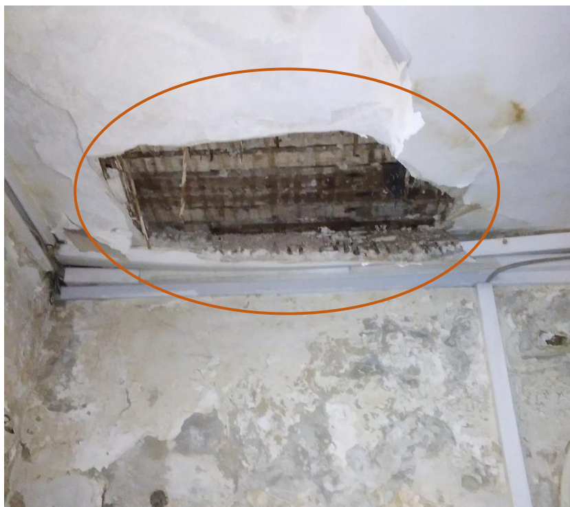
Foto nr. 13 – Degradări tavan rabiț subsol
