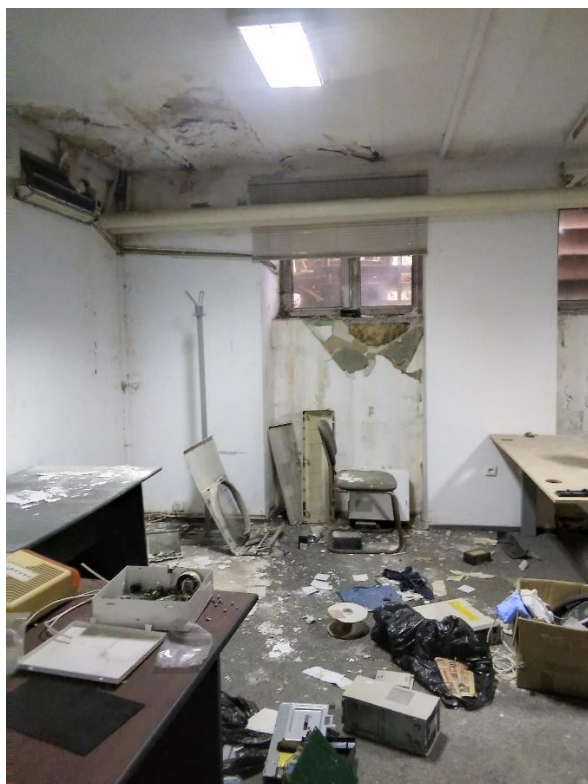
Foto nr. 12 – Degradări tencuială pereți subsol
