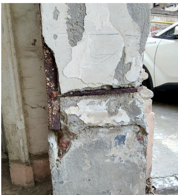
Foto nr. 9 – Tencuială căzută stâlpi consolidați gang
